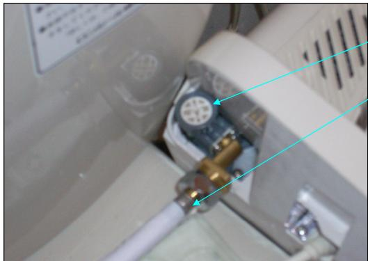
コインなどで水抜き栓をはずします。
