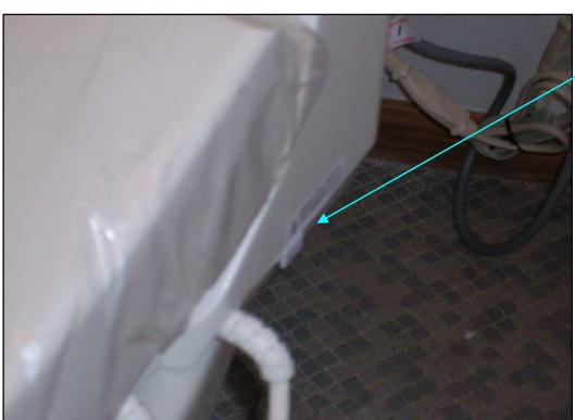
水抜きレバーを右に引き出します。
